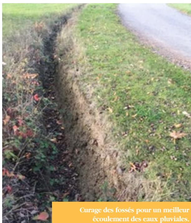
Curage des fossés pour un meilleur écoulement des eaux pluviales.
