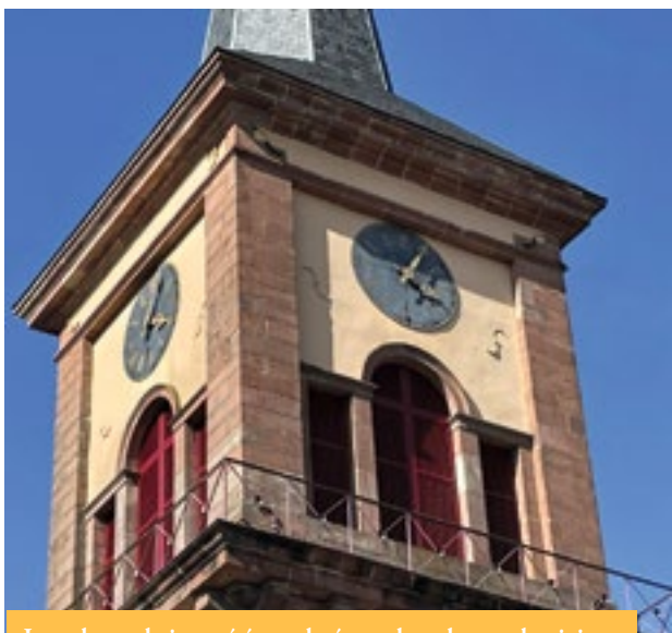
Les volets en bois ont été remplacés par des volets en aluminium.
