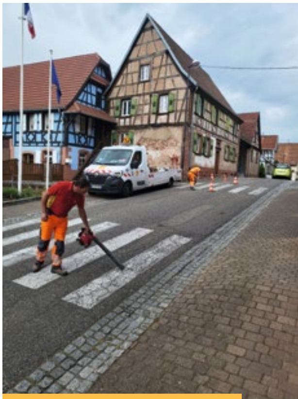
Une peinture spéciale, répondant à différentes normes, a été appliquée sur les passages pour piétons.
