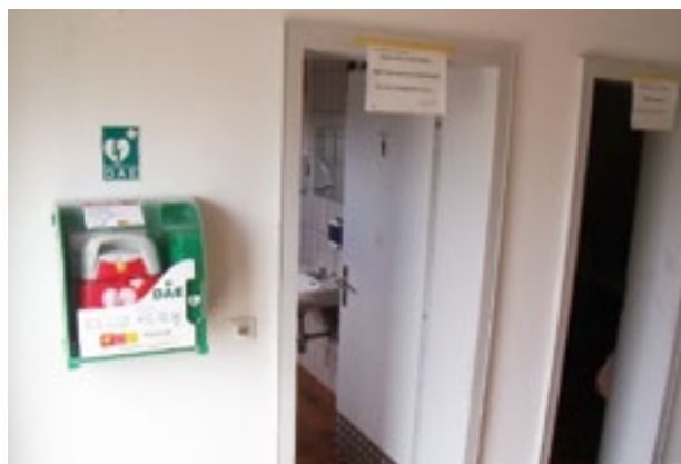
... et un dernier au rez-de-chaussée de la salle polyvalente.
