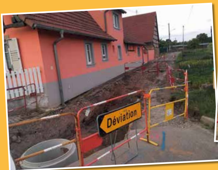
LES TRAVAUX ONT DURÉ HUIT SEMAINES.
