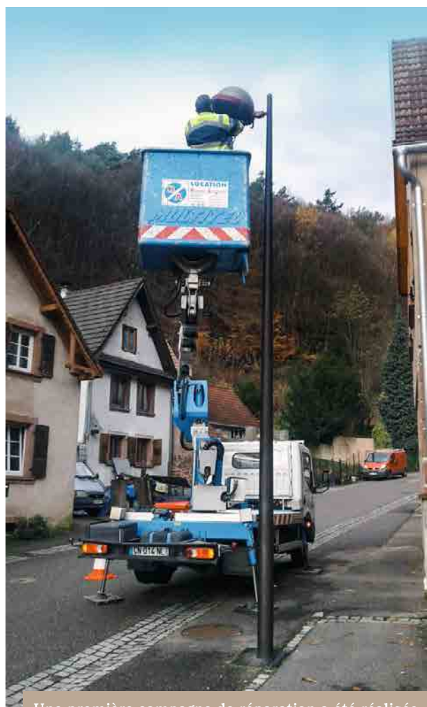
Une première campagne de réparation a été réalisée en novembre dernier par nos agents techniques.
