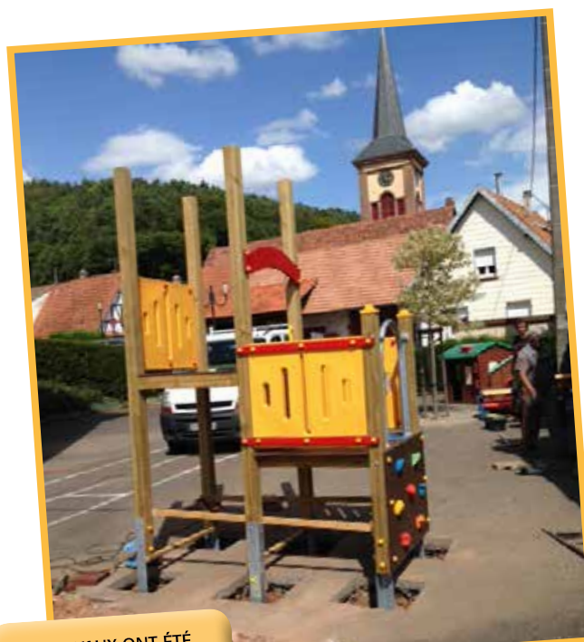
LES TRAVAUX ONT ÉTÉ RÉALISÉS DURANT L'ÉTÉ
