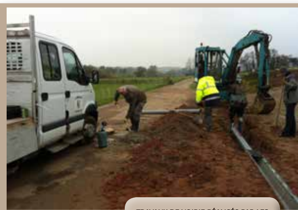
TRAVAUX DE VOIRIE RÉALISÉS PAR LES ÉLUS DANS LA RUE DES BERGERS
