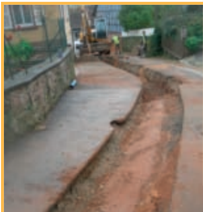
LA CONDUITE PRINCIPALE DE DISTRIBUTION DE L'EAU POTABLE A ÉTÉ REMPLACÉE.
