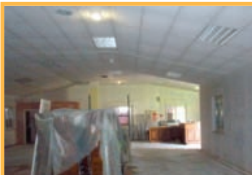
LES TRAVAUX ONT DURÉ PRÈS DE TROIS SEMAINES.
