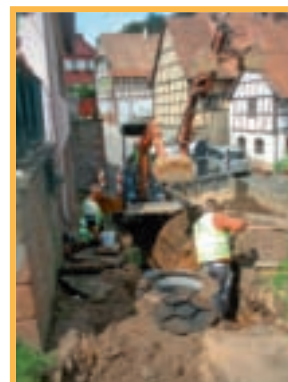
LES TRAVAUX D'EAU ET D'ASSAINISSEMENT ONT ÉTÉ PRIS EN CHARGE PAR LE SYNDICAT DES EAUX D'OFFWILLER ET ENVIRONS.
